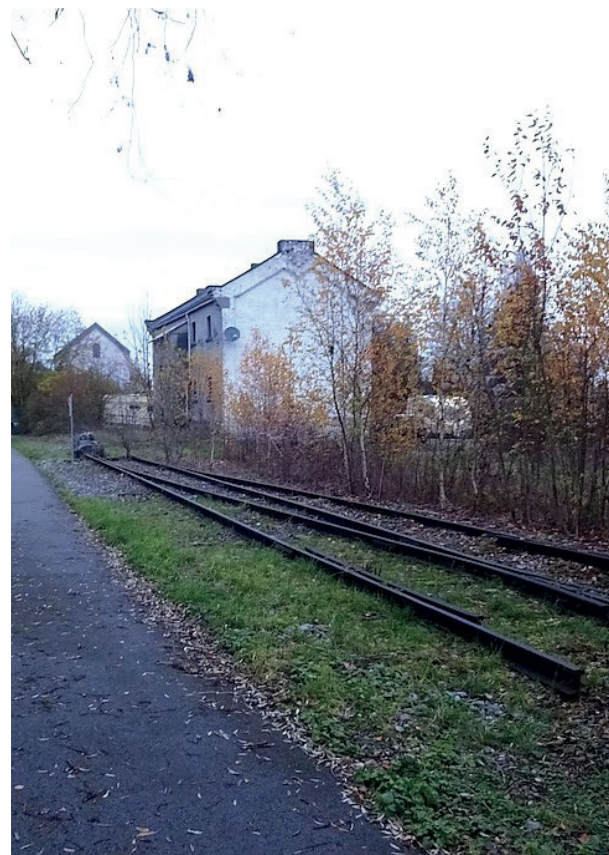
Arrière de la gare
