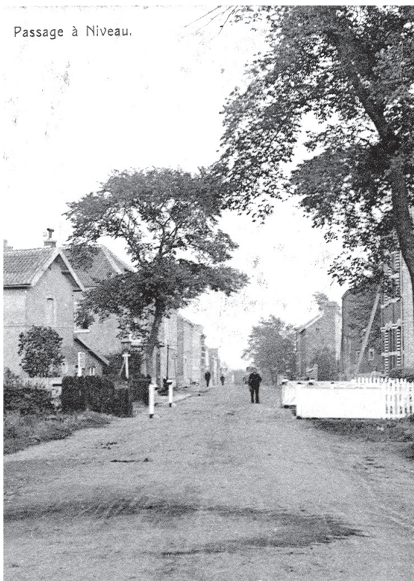
Passage à niveau
