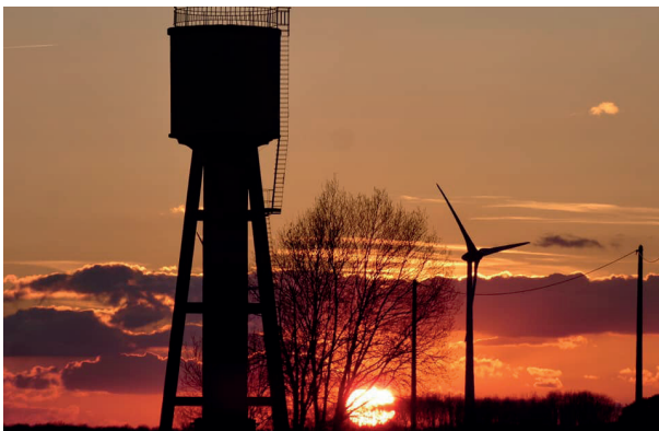
Château d'eau de Bambois - Photo Francis Vandenbrouck
